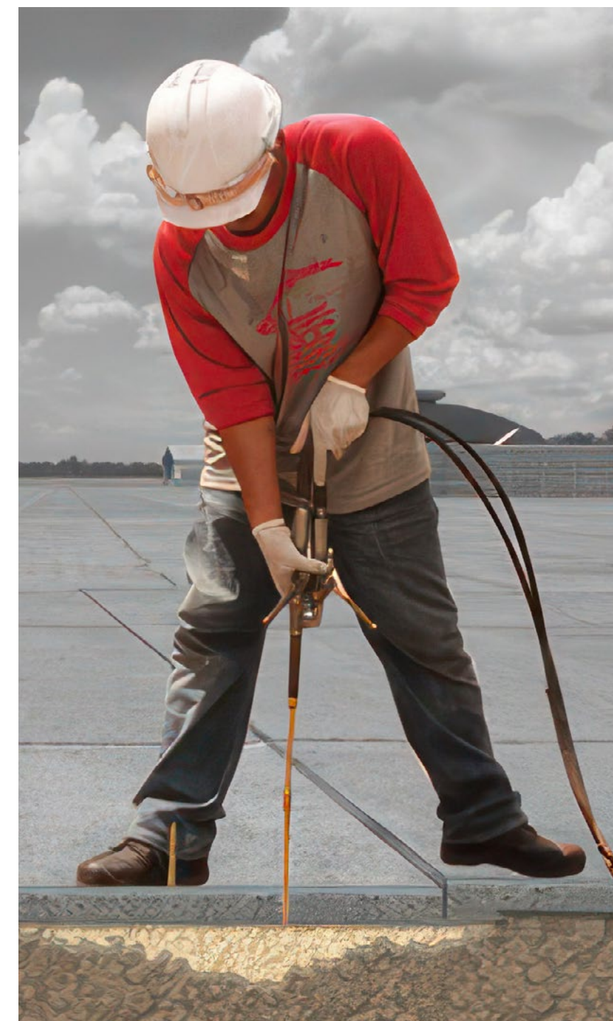
Stačí vyvrtat díry o průměru 10 mm do betonové desky a těmito otvory aplikujeme určité množství pěny, která během několika vteřin začne chemicky reagovat a zvětšovat svůj objem. Tímto způsobem je možné vyzvednout až několik desítek tun na 1 m 2 .
