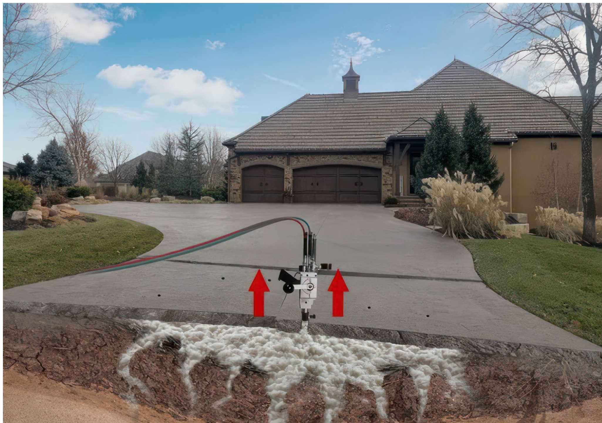
Pomocí technologie SlabLifting můžeme zvedat velmi hmotné stavební konstrukce v rekordně krátkém čase, bez prachu, hluku a vibrací.
